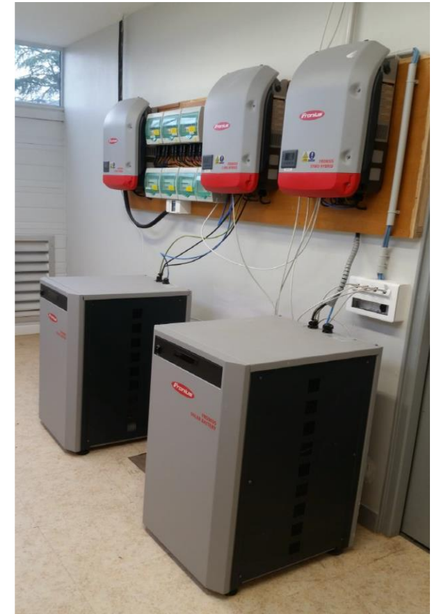
Onduleurs Fonus et batteries de 9 KvA
